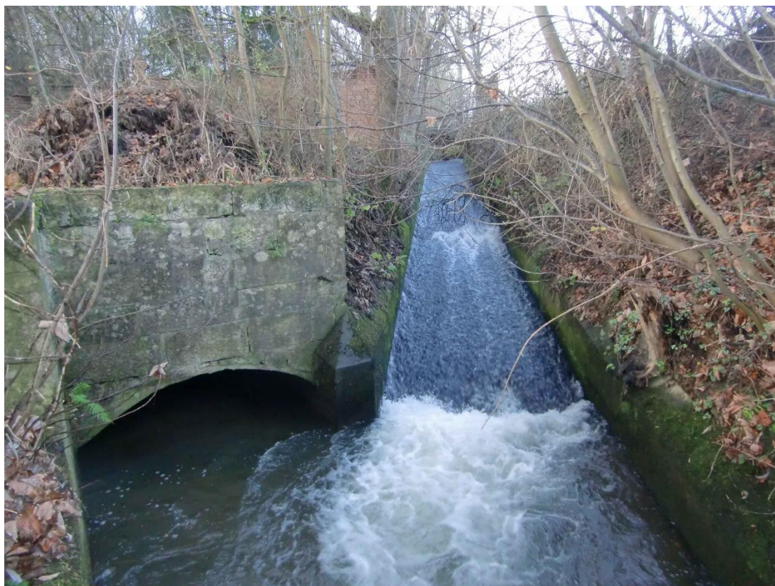
Foto der Beton-Rinne an der Wehranlage, 2016
