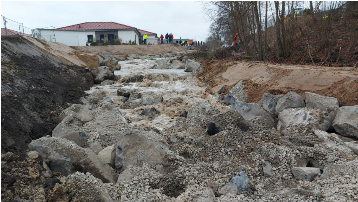
Foto bei der Flutung des Riegel-Becken-Passes, 18.12.2024
