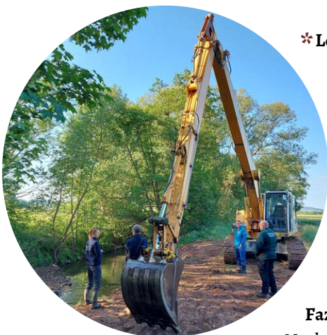
Foto: Eine Voraussetzung für die erfolgreiche Umsetzung des Projektes war nicht nur die Arbeit der Gewässerallianz, sondern auch die sehr konstruktive Zusammenarbeit des Leineverbandes mit den Behörden und der ausführenden Baufirma [Leineverband, 2022].
